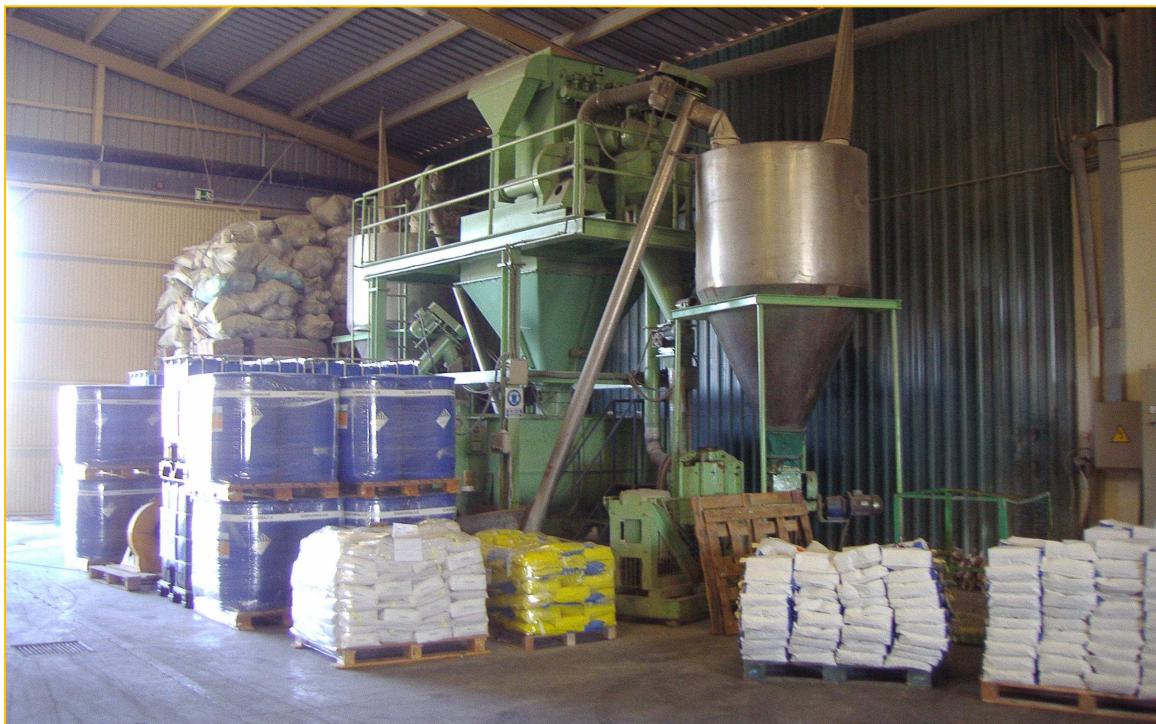
Fotografía: Imagen de Instalación industrial en Extremadura
