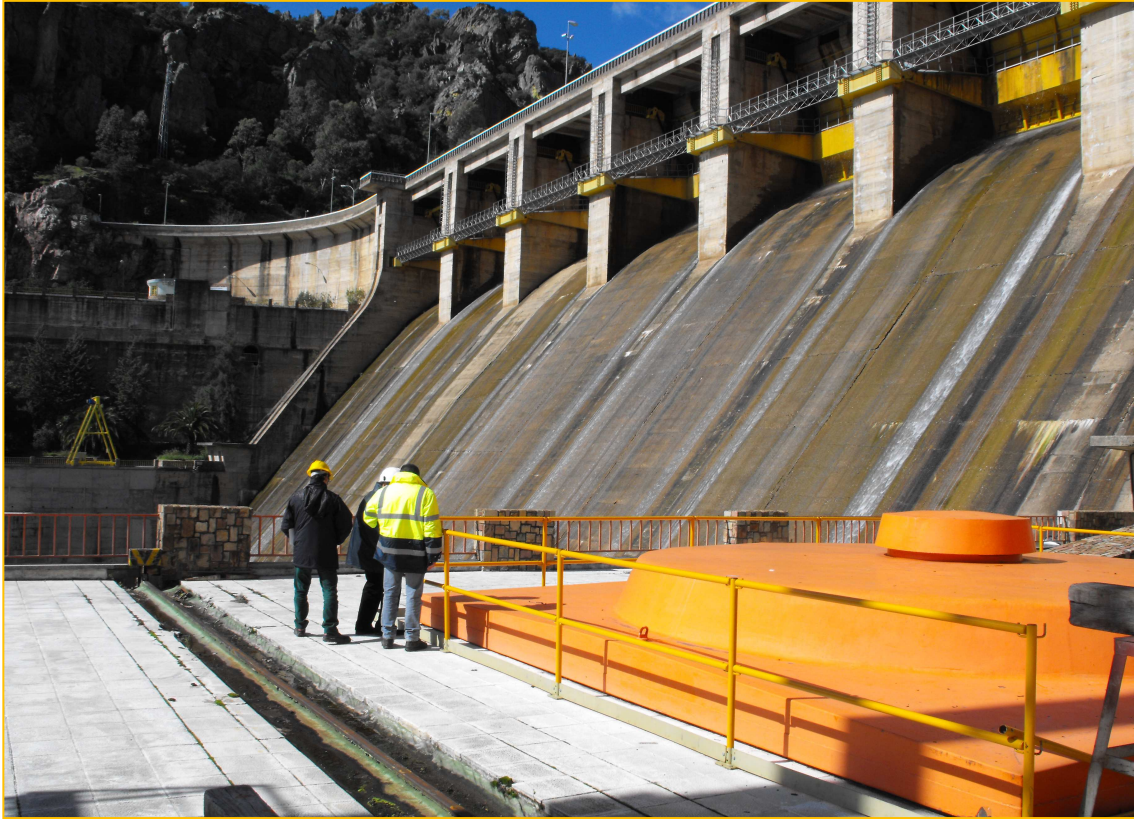
Fotografía: Inspección a central hidroeléctrica
