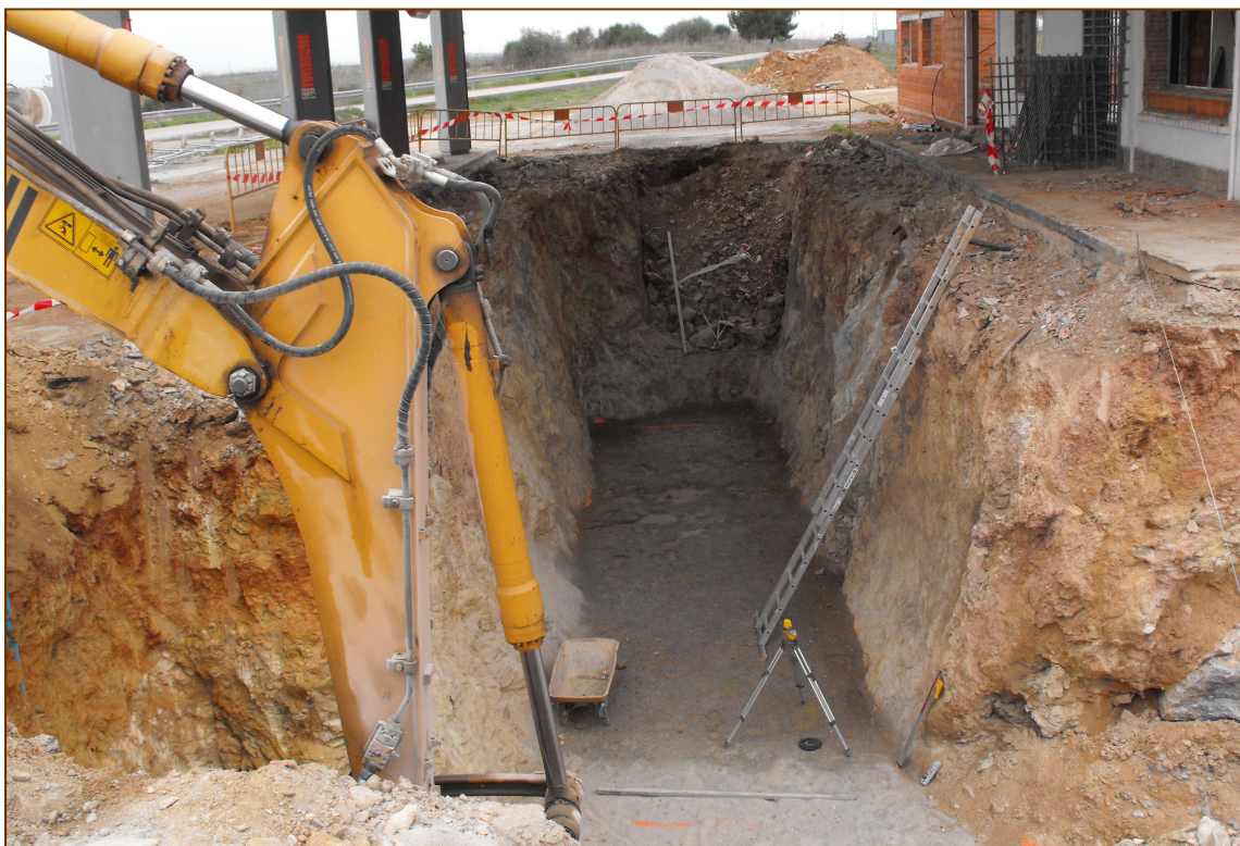
Fotografía: Excavación del foso de antiguos tanques de combustibles.
