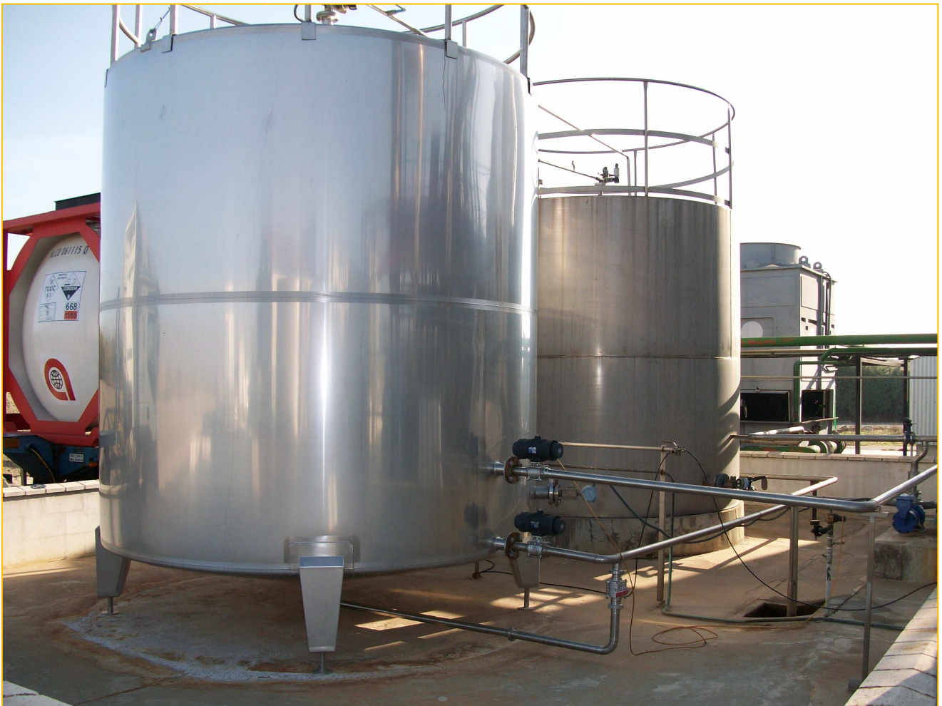
Fotografía: Imagen de Instalación industrial en Extremadura
