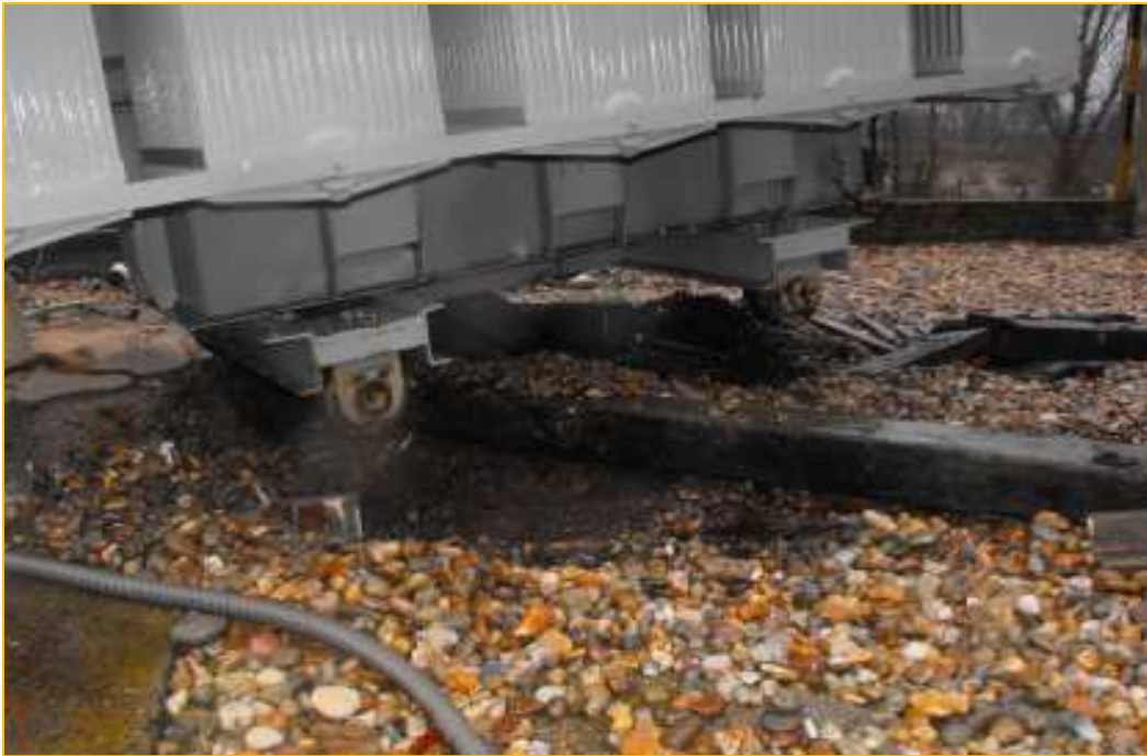
Fotografía: Vertido de aceite térmico de transformador
