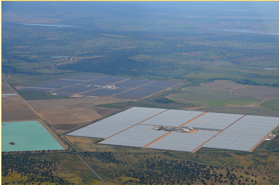
Fotografía: Imagen aérea huerta solar en Extremadura
